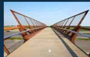
Bicycle bridge Hoofddorp (NL)
