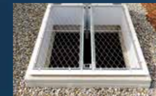
Durchsturzicherheit Langnau im Emmental (CH)
