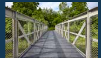
Fussgängerbrücke Glatt Zürich (CH)
