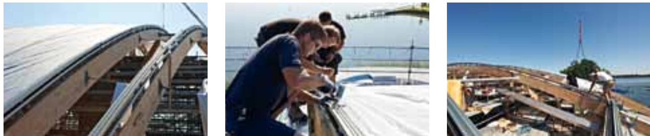
Verbessert wurde auch die Verbindung zwischen Holz und pneumatischer Konstruktion. Kondensat kann jetzt optimal abgeleitet werden. | The connection between wood and pneumatic design was improved, too. Water condensation can now run off in an optimum way.
